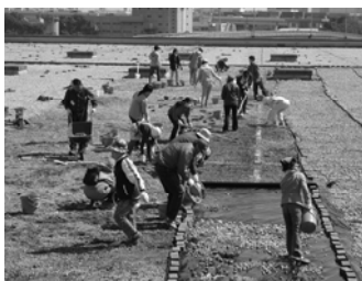
シート敷設状況
