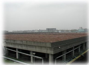
スラッジライトに覆われた屋上
