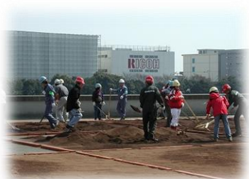
スラッジライトを敷きならす
